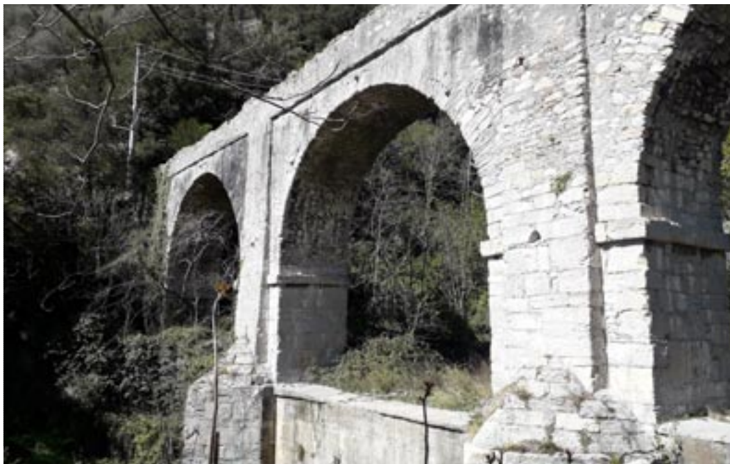
Ponte Canale sul torrente Geirato
