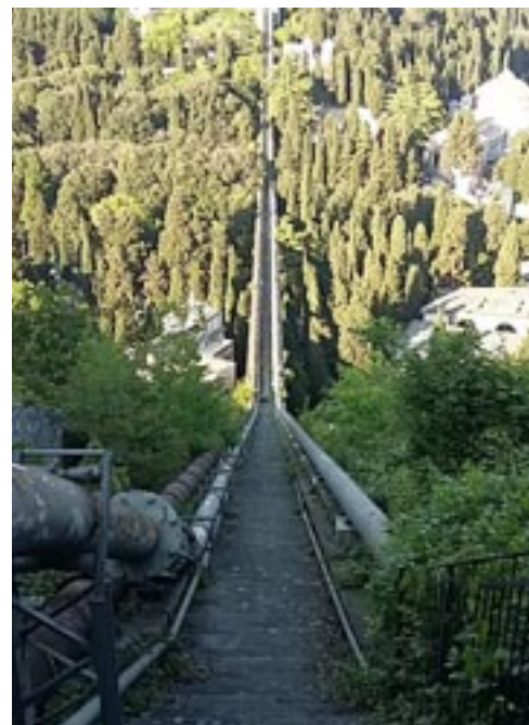
Acquedotto ponte Sifone Veilino
