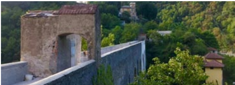
Ponte Cavassolo sul Rio Concasca
