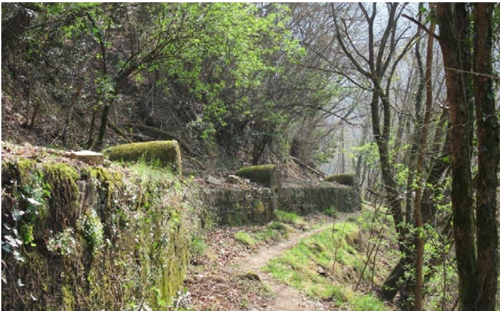
Serie di Filtri La Presa -Cavassolo
