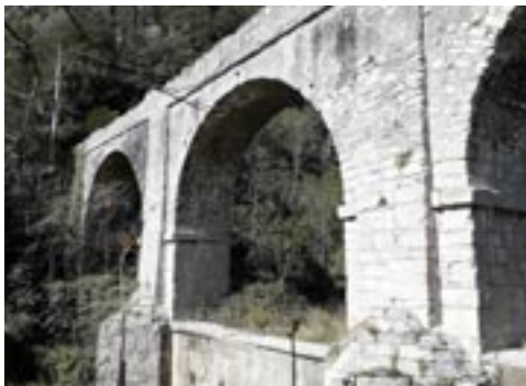
Ponte Canale sul Torrente Geirato
