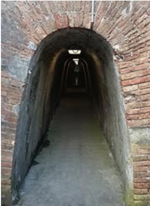
Galleria di sbocco al ponte Sifone sul Veilino
